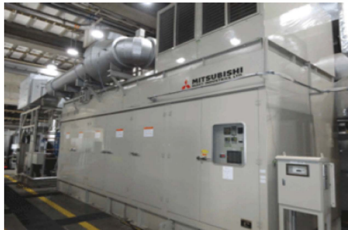
発電設備外観
