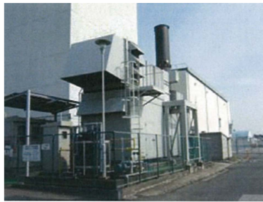
実証試験設備
