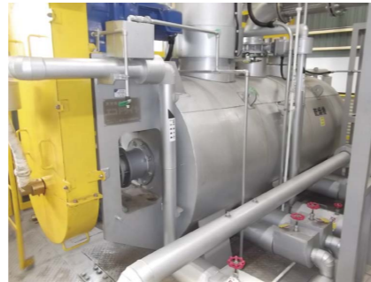
汚泥真空乾燥装置(播磨工場)
