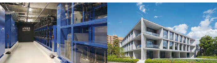
(左)太陽光発電の余剰電力で水素を製造・貯蔵し、燃料電池で発電する「CO 2 フリー水素エネルギー利用システム」
