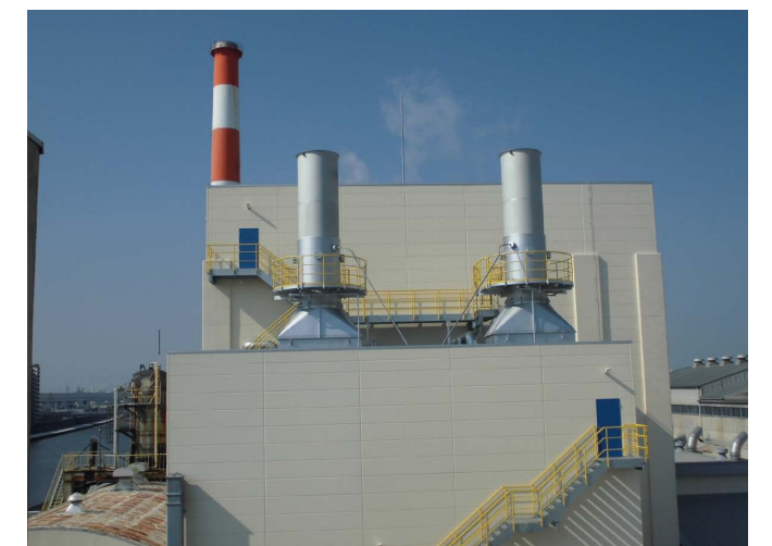
【更新GT 建屋外からの写真】
