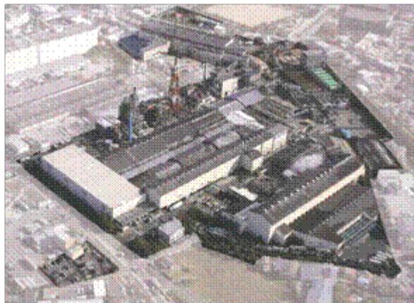
図-1 レンゴー（株）八潮工場の全景（*1）
