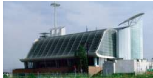
写真-1 竣工当時のアースポート
