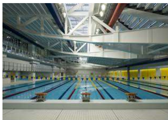
図-5 屋内プール (*1)
