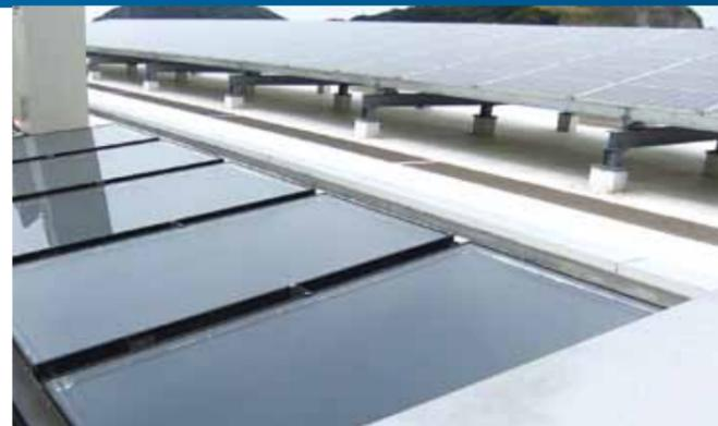
写真③ 太陽熱利用温水供給設備(矢崎エナジーシステム(株))
