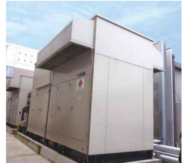
写真① 更新後のガスエンジンコージェネレーション
