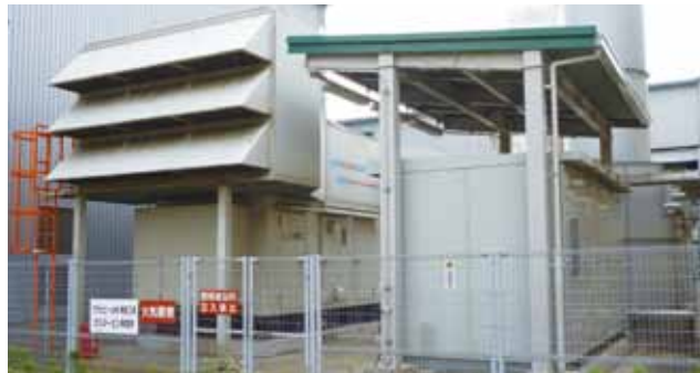
写真① ガスタービン発電装置と発電機盤
