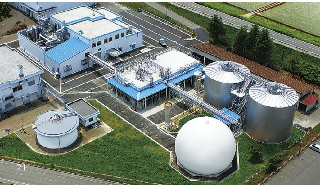
微生物が活動しやすい約40℃に保たれ、メタン発酵が行われることにより1日当たり8900Nm<sup>3</sup>のバイオガス（メタンガス）を発生させる。槽内の加温にはコージェネレーション設備のジャケット冷却水の排熱を利用する仕組みになっている。発生したバイオガスは脱硫装置にて硫化水素を取り除いた後、ガスホルダーに蓄えられる。
