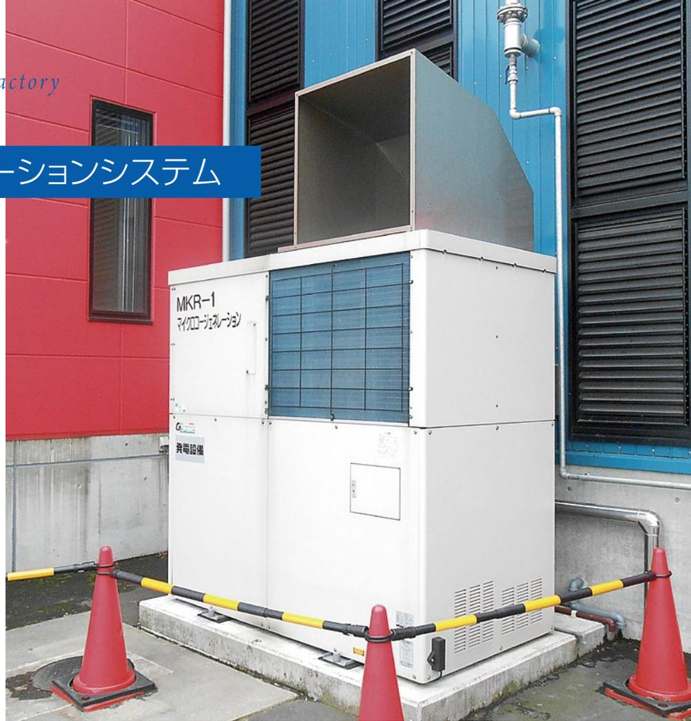
気ボイラーの使用量を削減する。コージェネ導入前は、水温から洗濯機の必要温度である40℃まで昇温するのに蒸気だけを使っていたが、コージェネの排熱を使うことで蒸気量が削減された。なおコージェネはヤンマーエネルギー
