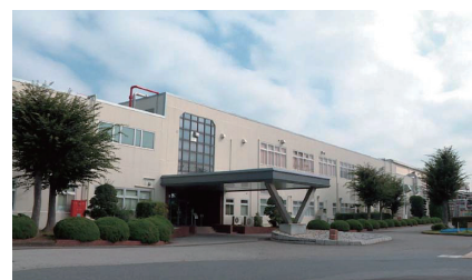
群馬第1工場外観
