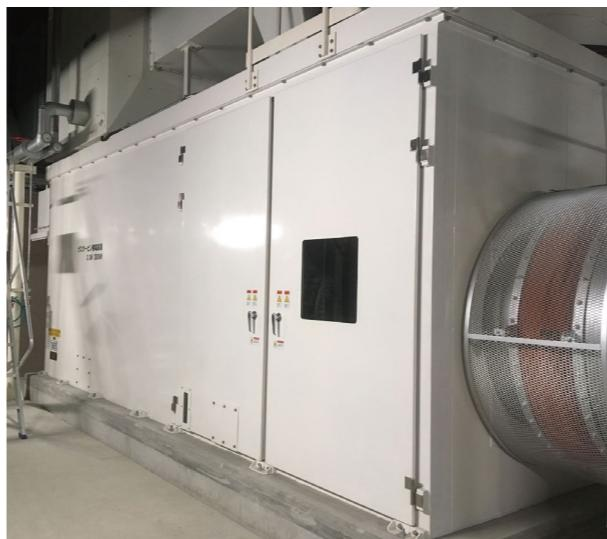
【出力可変型排ガス追焚蒸気ボイラ】
