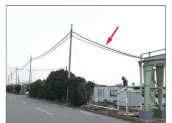
新設した自営線（矢印）
