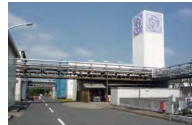
久喜工場構内
