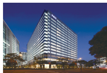
横浜野村ビル外観
