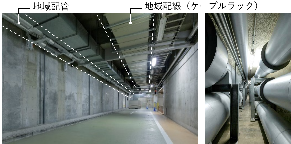
▲既存建物内の地下駐車場車路
