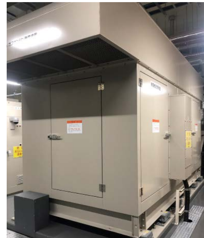
天然ガスCGS ※エリア総電力 (1,200 kW想定) の約53%の容量
