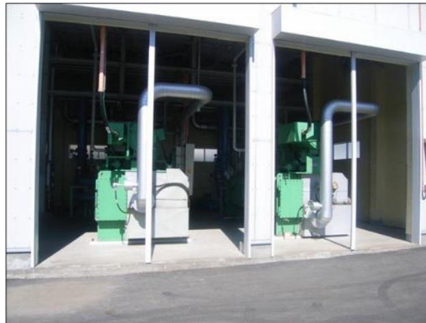
ターボ冷凍機 (1,628kW × 2基)
