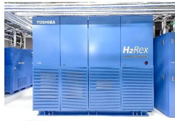
燃料電池設備
