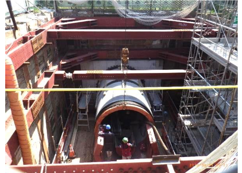
推進工法（県道横断）
