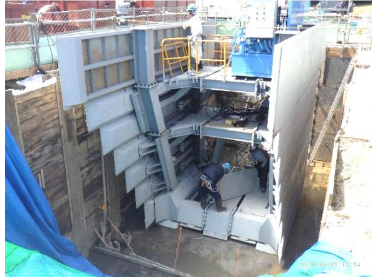
オープンシールドマシン
