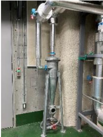
サンドセパレータ (井戸水の砂除去)
