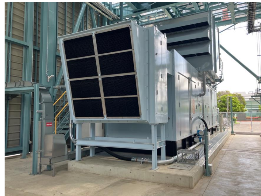
【4号CGS（1階：ガスタービン・発電機）外観】
