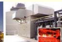
ガス発電設備
