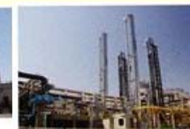
消化ガス精製設備
