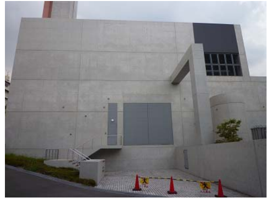
エネルギーセンター全景 2
