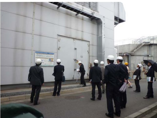
ガスエンジン収納建屋
