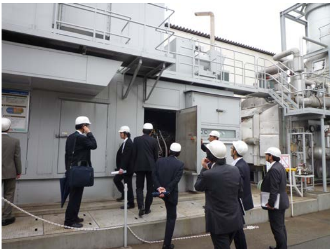
ガスタービンエンクロージャー
