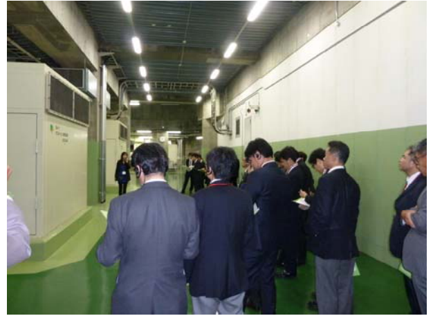
ガスタービンコージェネレーション (2,000kW×2台)
