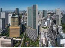
(左) 1253kWのガスエンジンコージェネ (右) 複合施設「赤坂インターシティAIR」。環境負荷低減とBCP強化をテーマに再開発を推進した。ガスエンジンコージェネ2台を導入。隣接地区の地域冷暖房と連携し排熱を有効活用する
