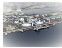
(左) オーバーホールとガスエンジンの高効率化改造工事で燃料ガスの7%削減に成功した (右) 既設コージェネの高効率化改造工事を行った広島ガス廿日市工場
