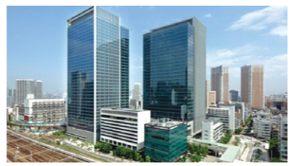
「msb Tamachi」は大規模ガスコージェネシステムを核に電気・熱・情報のネットワークを構築し需給連携を実現する
