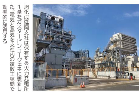
旭化成延岡支社は保有する火力発電所1基をガスタービンコージェネに更新した。電気と蒸気を支社内の複数工場間で効率的に活用する。
