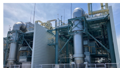
ガスタービンコージェネを増設し、余剰電力を他拠点へシェアする電力融通システムを構築した。さらに、既設コージェネを国内初の水素混焼対応型に更新した
