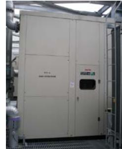
図-4 排熱投入型ガス吸収式冷温水機外観
