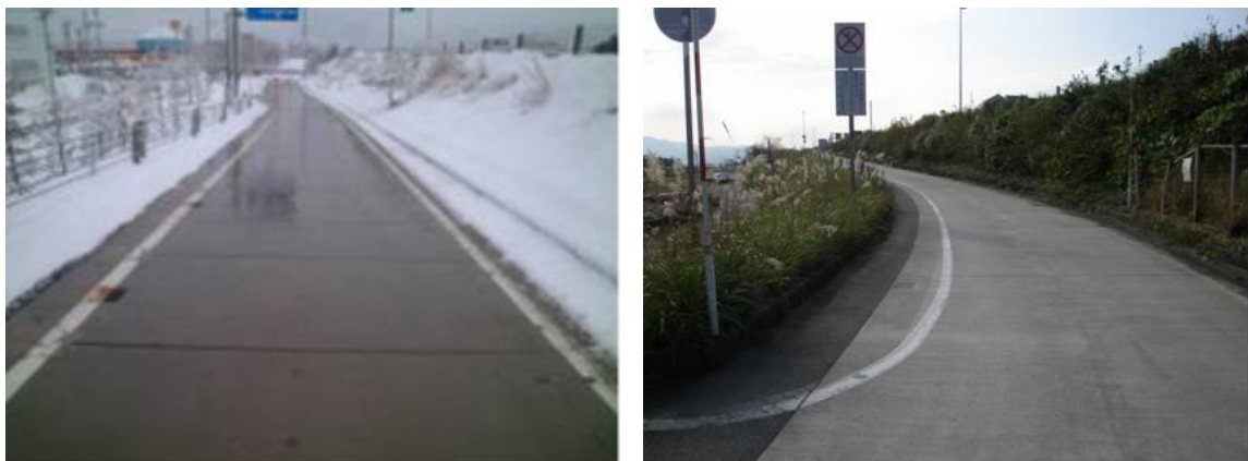
図-2 富岡 IC 上りランプでの融雪状況（左図は冬期(*2)、右図は取材時（2011 年 11 月））
