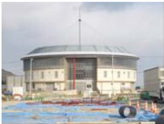
図-9 ネットワークポンプ棟
