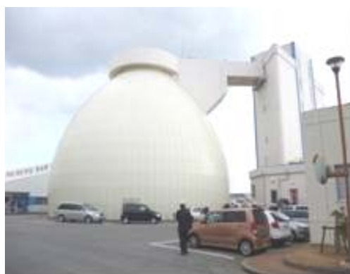
図 - 2 汚泥消化タンク
