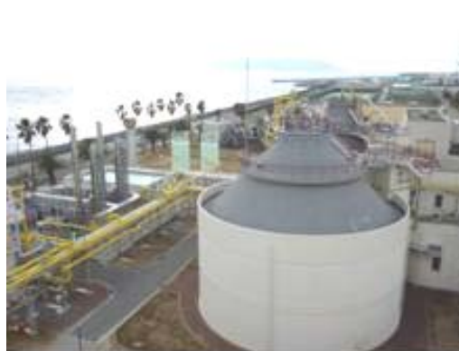
図 - 3 消化ガス精製設備等 (左奥)
