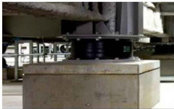
図-8 免震装置（積層ゴム）<sup>(※3)</sup>
