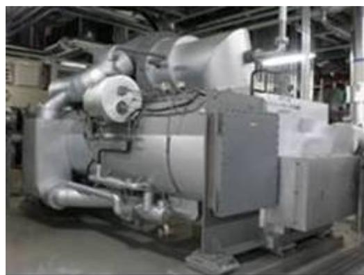
図 - 6 インバータターボ冷凍機
