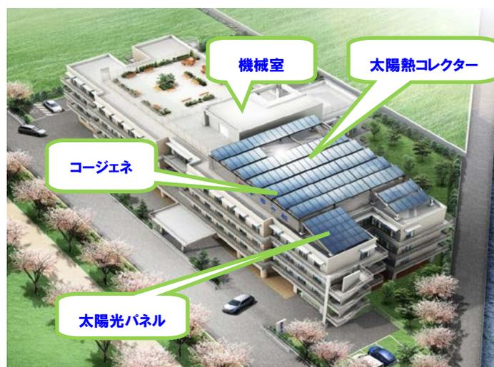
熱はバッファータンクに回収され温水熱媒の昇温に利用されている。尚、太陽熱とコージェネ廃熱による温水の昇温が不十分な場合は、バックアップ用のガス温水ボイラーにて昇温が可能なシステムとなっている。太陽光パネル（4.5kW）で発電した電力はパワーコンディショナー・受変電設備を経由し電灯回路に系統連系されている。
