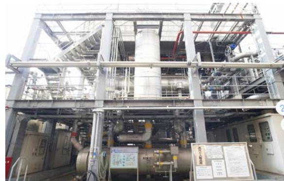
**図-4 アンモニア吸収式冷凍機**
