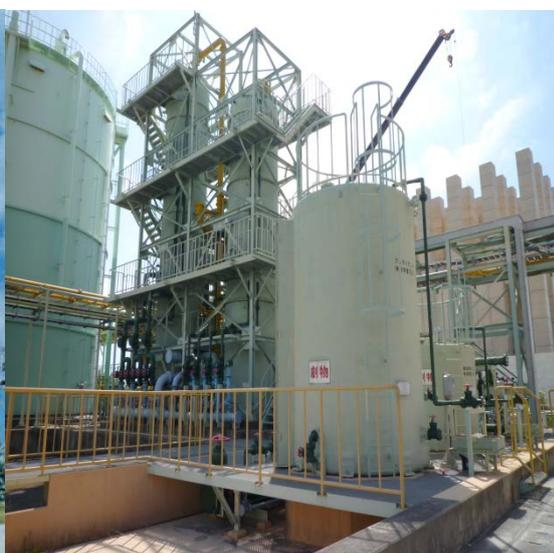
(図-4 消化ガス精製設備等)
