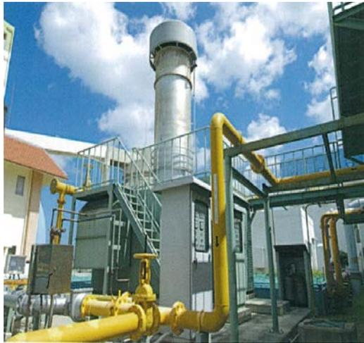
図-1 3 余剰ガス燃焼装置
