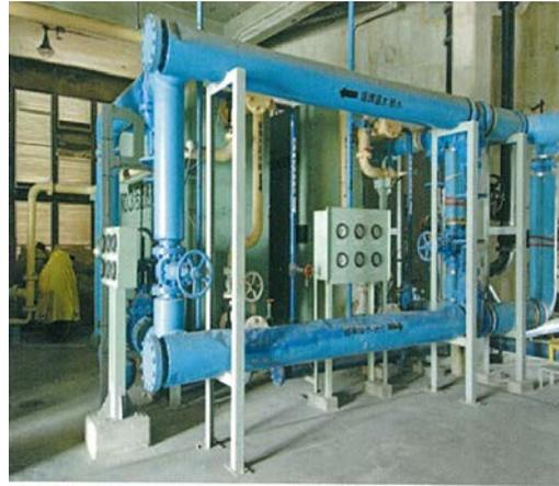
図-1 3 汚泥熱交換器
