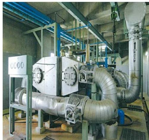
図-11 温水器熱交換器
