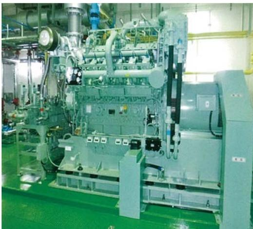
図-10 消化ガス発電装置
