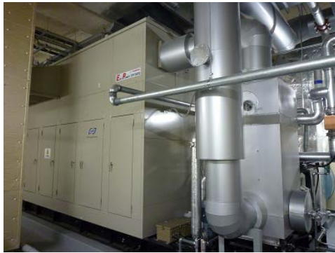
図-5 ガスエンジンコージェネレーション 350kW × 1
