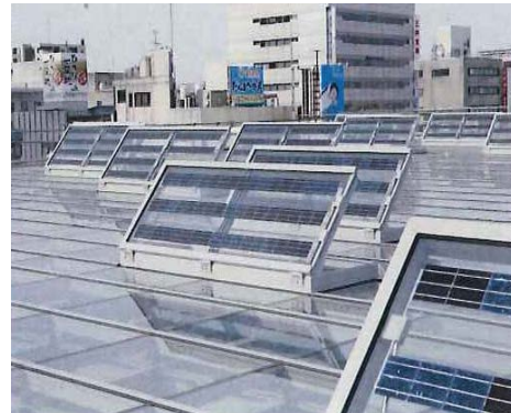
図-8 太陽光発電・換気システム
