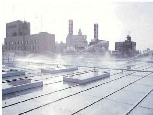
図-7 中水循環型融雪システム
