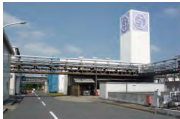
久喜工場構内
