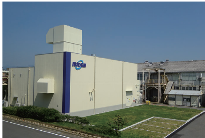
ガスエンジン(河間事業場)
