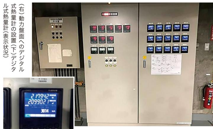
(左)動力盤面へのデジタル式熱量計の設置(下)デジタル式熱量計表示状況
