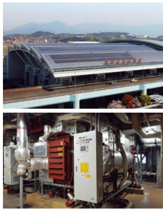
ガスエンジンコージェネ(815kW×1台)
