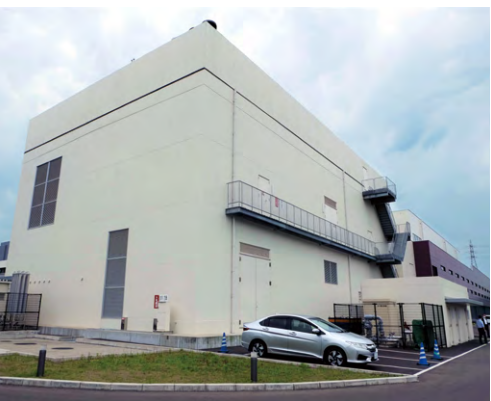
エネルギーセンター棟(外観)
