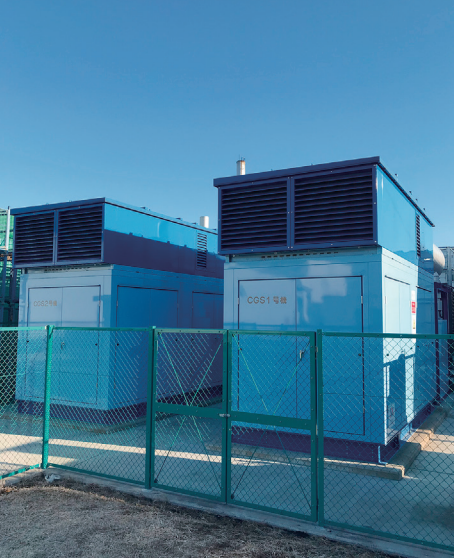
【設備設置状況】
