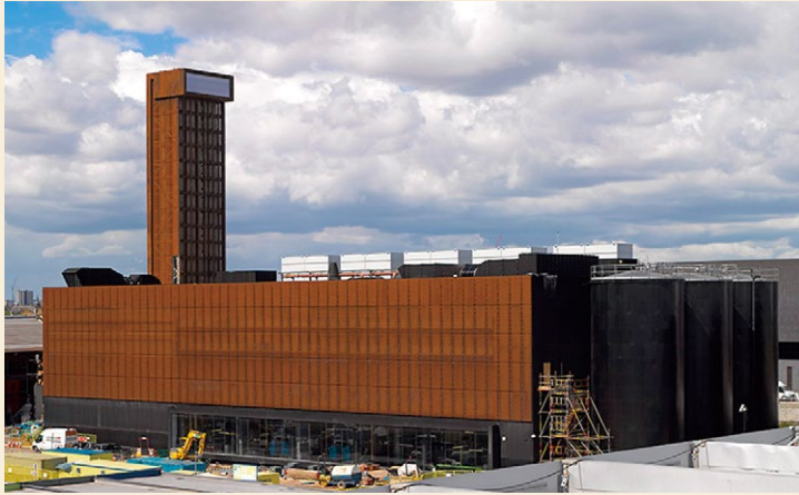
図2 キングス・ヤード・エネルギーセンター。2016年3月筆者撮影
