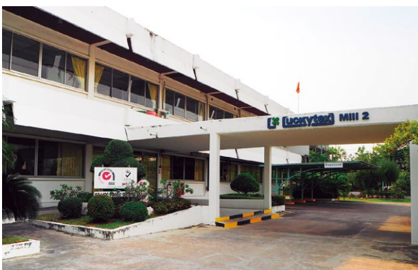
Luckytex(Thailand)Public CompanyのMill No.2工場
