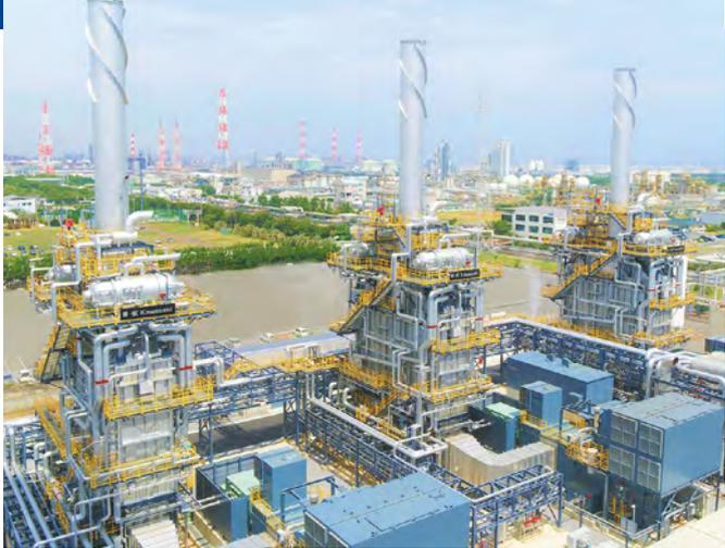
32.3MWガスタービンコーージェネ3台などを利用したコンバインドサイクル発電プラントを導入。鹿島東部コンビナート内の熱電需要の変化に対応し電気と蒸気を最適に供給、28%のプラント総合効率改善を達成した
