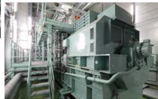
世界最高クラスの発電効率を誇るコージェネ7800kW×3基を導入した
