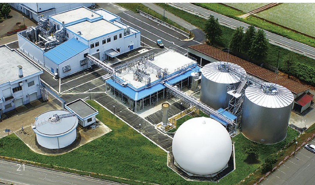
長岡市生ごみバイオガス発電センターの全景
