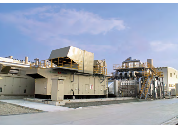
(上) 筑後川に隣接する味の素九州事業所。重油から天然ガスへの燃料転換のため、構内に中圧ガス導管を引き込んだ (左) 8MW級の最新式ガスタービンコージェネを導入し、一次エネルギー削減率を大幅に向上した
