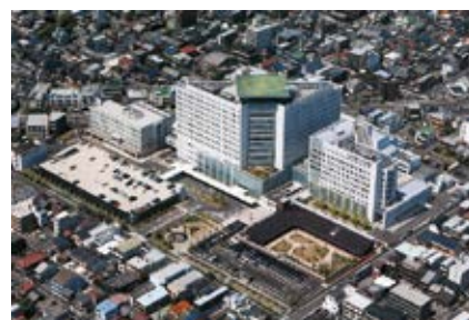
名古屋第一赤十字病院の外観
