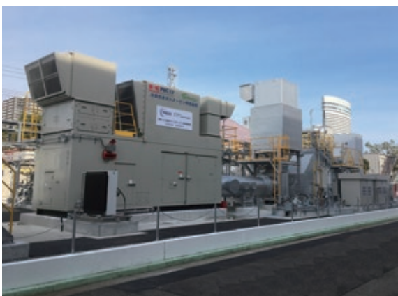
独自のマイクロミックス燃焼器を搭載した高効率1・8MW級ガスタービン
