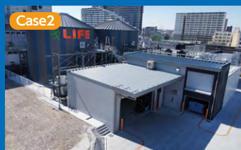
P.10 ライフ天保山 バイオガス発電設備
