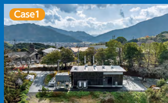
P.8 内子龍王 バイオマス発電所
